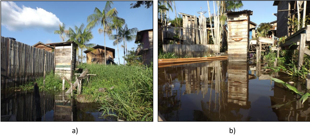
Figura 2: Aspecto dos banheiros no igarapé Santa Cruz, Breves, Pará, no período de março a abril/2017. a) sanitário situado às margens do igarapé Santa Cruz. b) sanitário situado dentro do igarapé Santa Cruz, próximo ao jirau de lavar louças.
