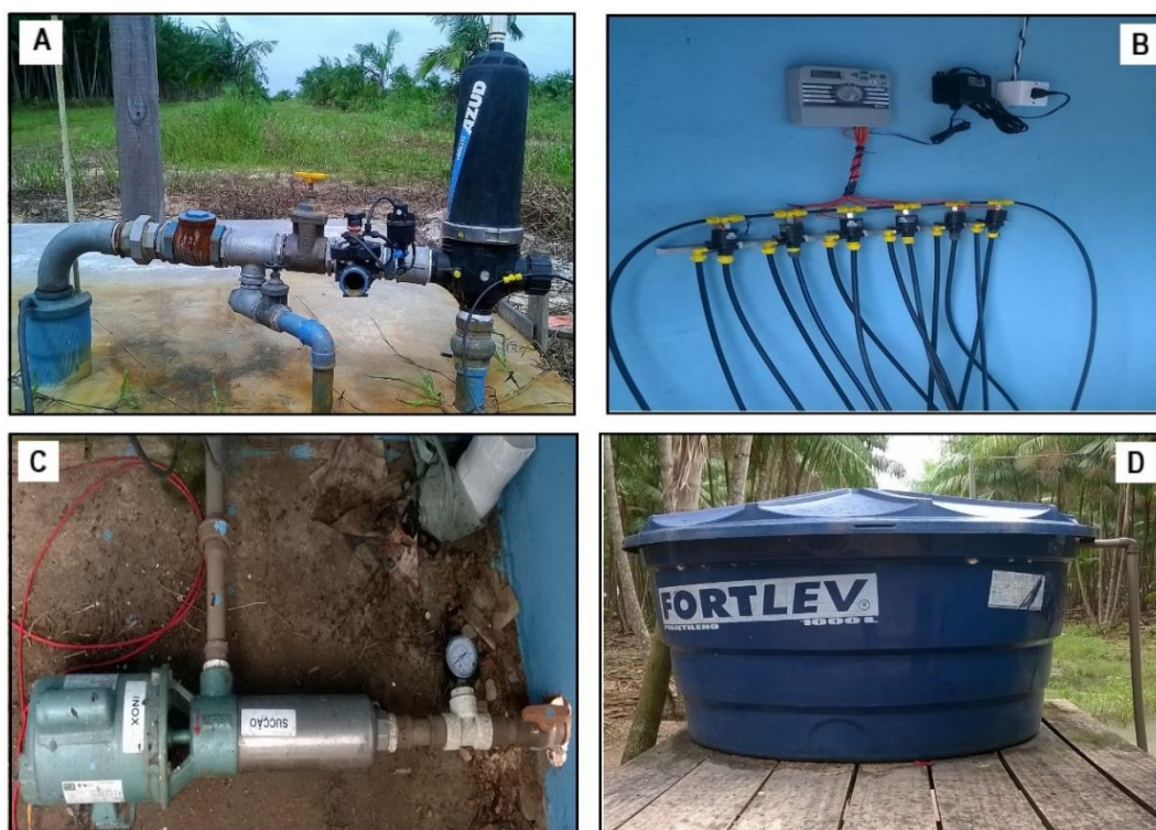
Figura 10. (A) Cabeçal de controle instalado na propriedade; (B) Painel de controle para automação da irrigação; (C) Bomba injetora de fertilizante e (D) Tanque de mistura da solução.
