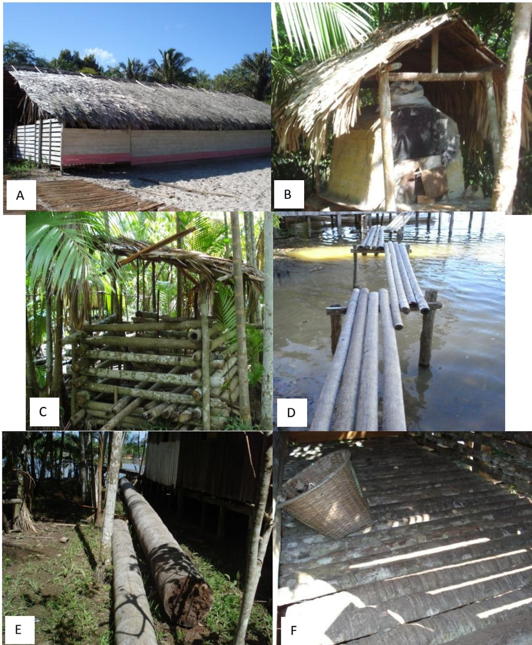
**Figura 8.** A-B. Utilização da palha do bussu/ palheira para a cobertura de barracões e depósitos; C. Caule do açai para construção de depósito/ casas dos animais; D. Idem para a construção de pontes; E. Caule da paxiúba para assoalhar depósitos; F. Caule do miriti utilizado como ponte.
