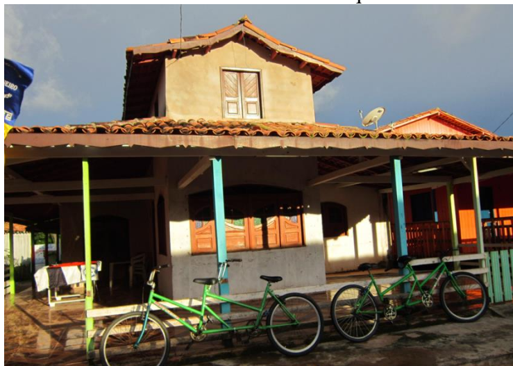
Figura 7: Moradia de alvenaria construída na Vila do Pesqueiro.
