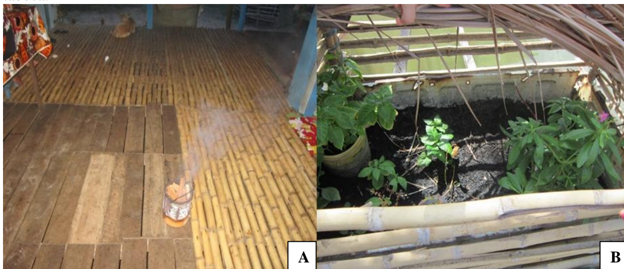
Figura 15: Espécies utilizadas para a construção. A – Assoalho feito com taboca ( Bambusa superba (Huber) McClure); B - Girau construído com taboca.
