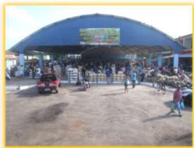
Imagem 9 - Galpão do Agricultor. Local de realização da feira. Fonte: Oliveira (2012, p. 43).
