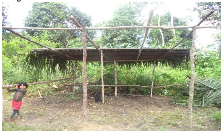
Fig. 19. Tekatáwa casa de ritual dos Assurini sendo construída
