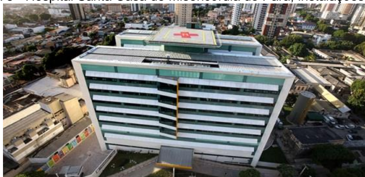
Figura 5 - Hospital Santa Casa de Misericórdia do Pará, instalações novas.
