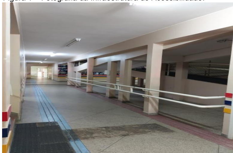
Figura 1 – Fotografia da Infraestrutura de Acessibilidade. 22
