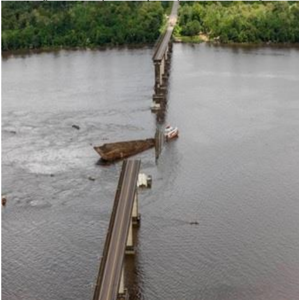
Figura 2 - Parte da ponte do complexo Alça Viária sobre o Rio Moju
