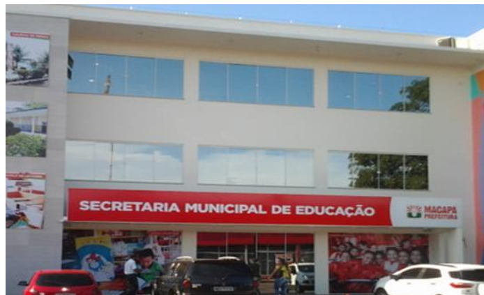
Imagem 1 – Fachada da SEMED de Macapá
