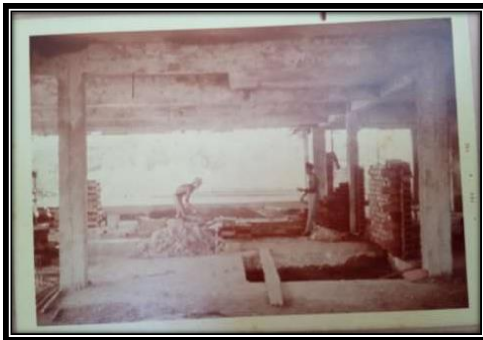
FIGURA 12 – CONSTRUÇÃO NO NOVO PRÉDIO DO INSTITUTO FELIPE SMALDONE EM BELÉM
