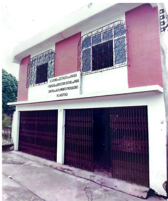
Figura 7 – Fachada do Centro de Acolhimento Provisório
