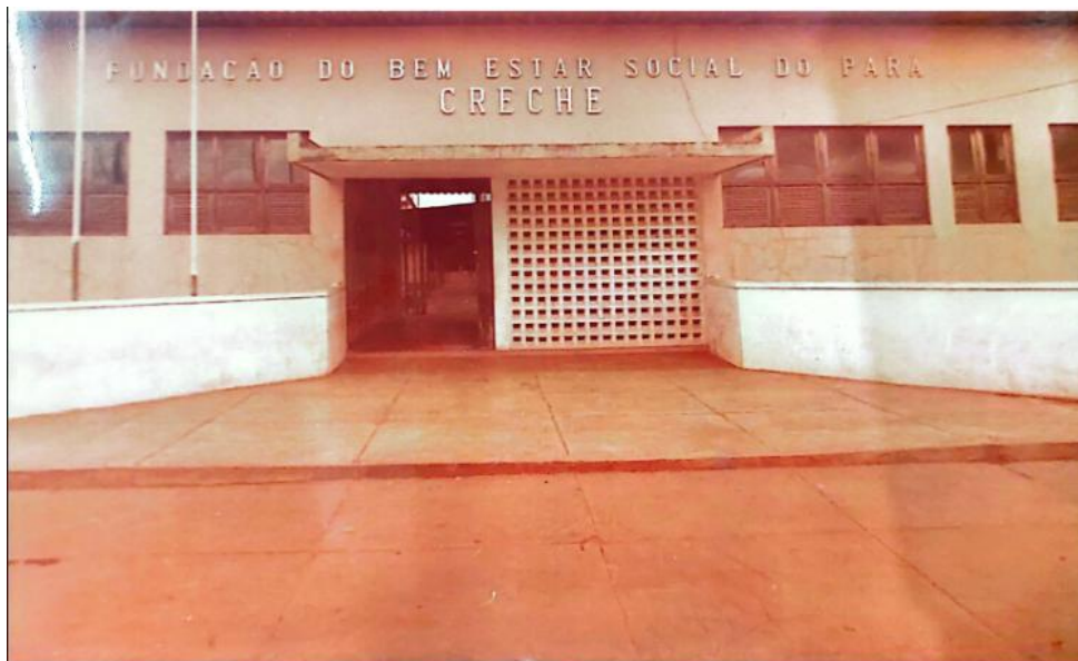
Figura 11 – Fachada da Creche Alacid Nunes
