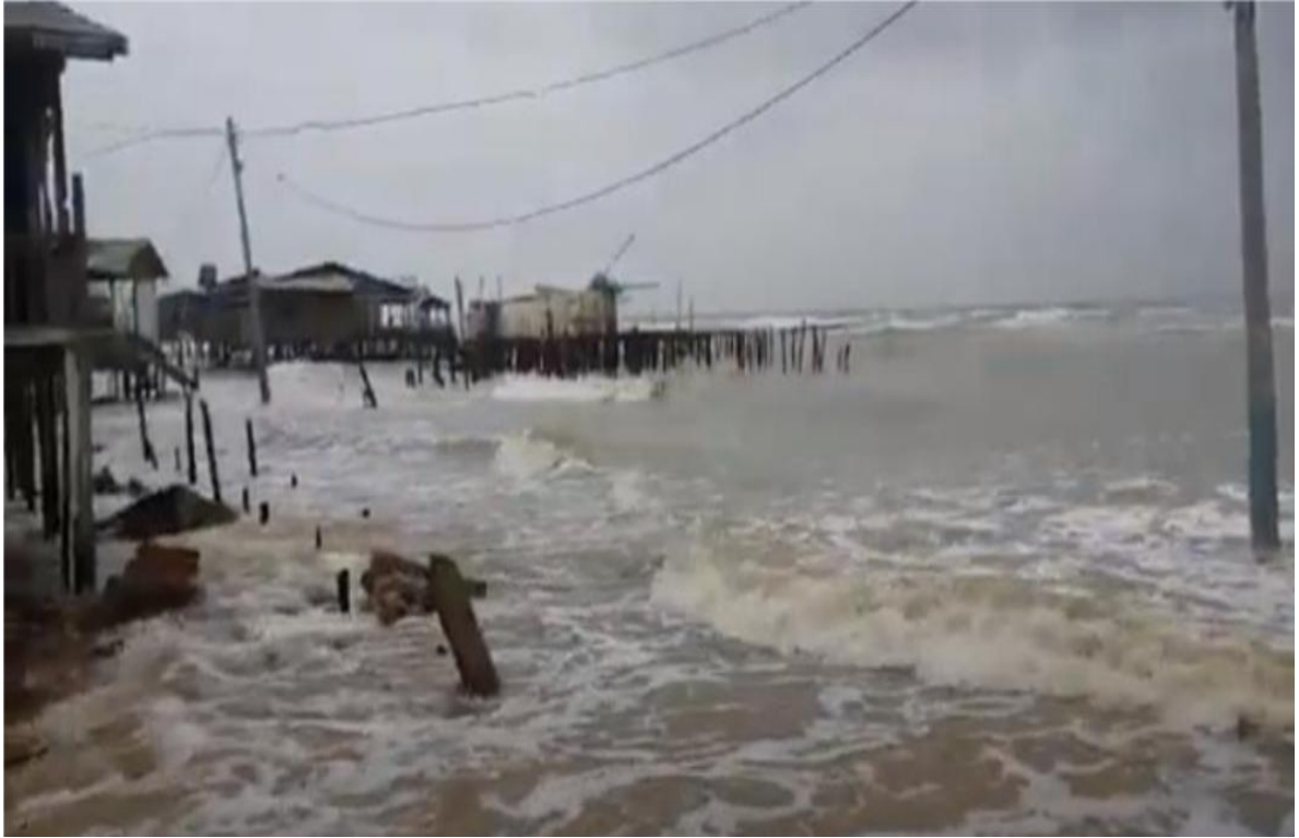
Imagem- 9 Movimentos da Maré ocasionada pela invasão de água e destruição da barricada
