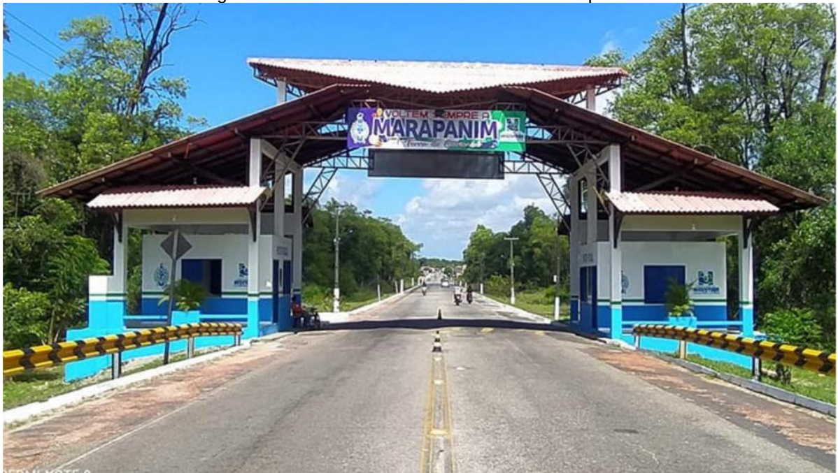
Figura 3– Portal da entrada da cidade de Marapanim
