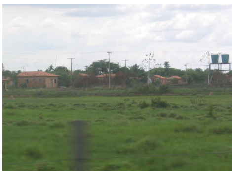
Fig.23: Vista parcial das casas.
