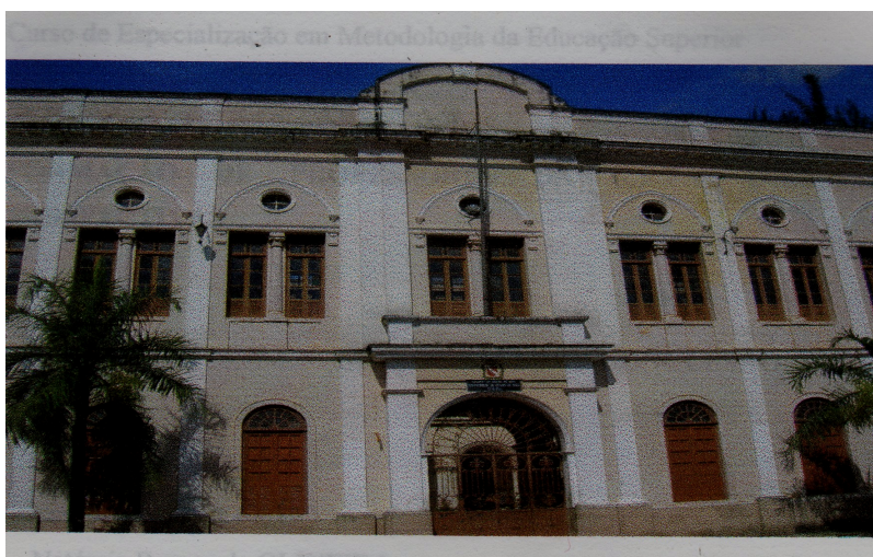
Foto 3: Prédio da antiga FEP, hoje Reitoria da UEPA – 2006.
