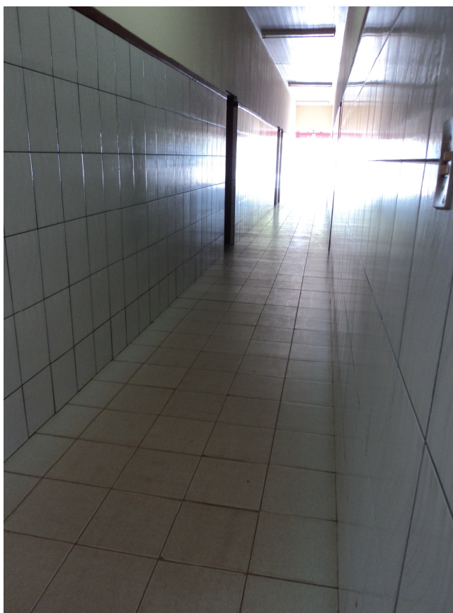
Fotografia 01 - Corredor de circulação
