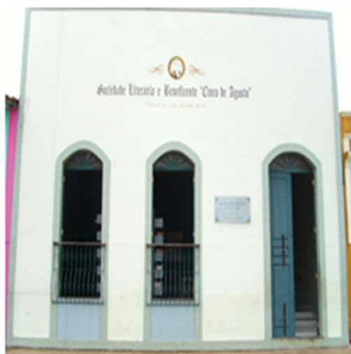
Foto 5 - fachada da sede da Sociedade "Cinco de Agosto" da cidade de Vigia inaugurada em agosto de 2007. Fonte: Soeiro, 2009.
