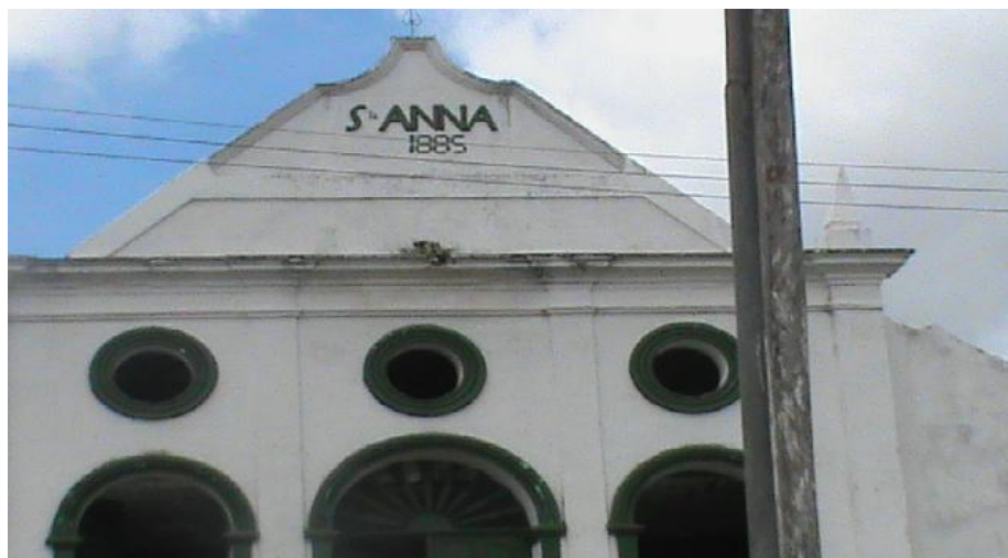
Foto 1 – Fachada da igreja de Nossa Senhora de Santana do Alto.
