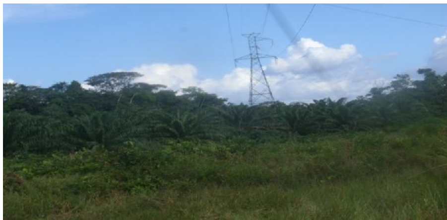
Foto 30 – Linha de transmissão da Valle e Dendê da Marborges.
