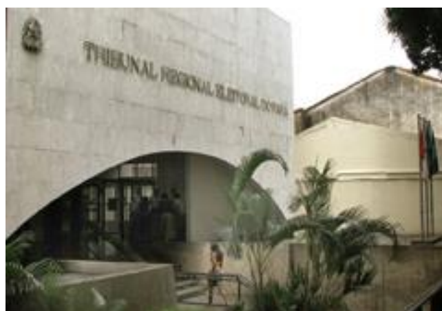
Figura 7 - Fachada atual do TRE-PA. Fonte: Acervo do TRE-PA.
