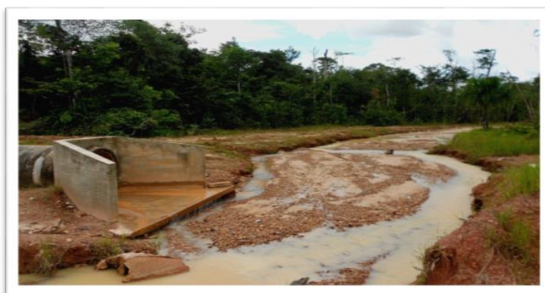
Foto 16 - Rede de esgoto que despeja em um afluente do Uriboquina. Fonte: Acervo da pesquisa, 2015.
