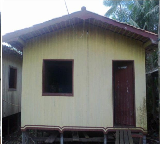
Foto 5 - Casa do Assentamento
