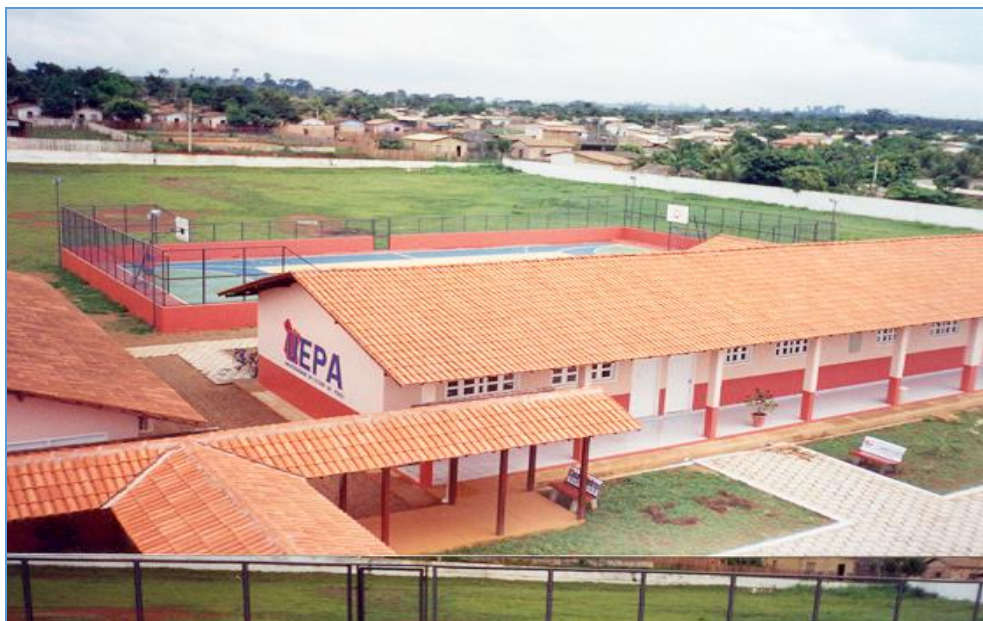
Figura 2 – Universidade do Estado do Pará, Campus IX Altamira.
