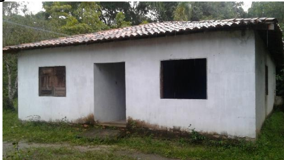
Figura 29: Dormitório da Casa Familiar Rural
