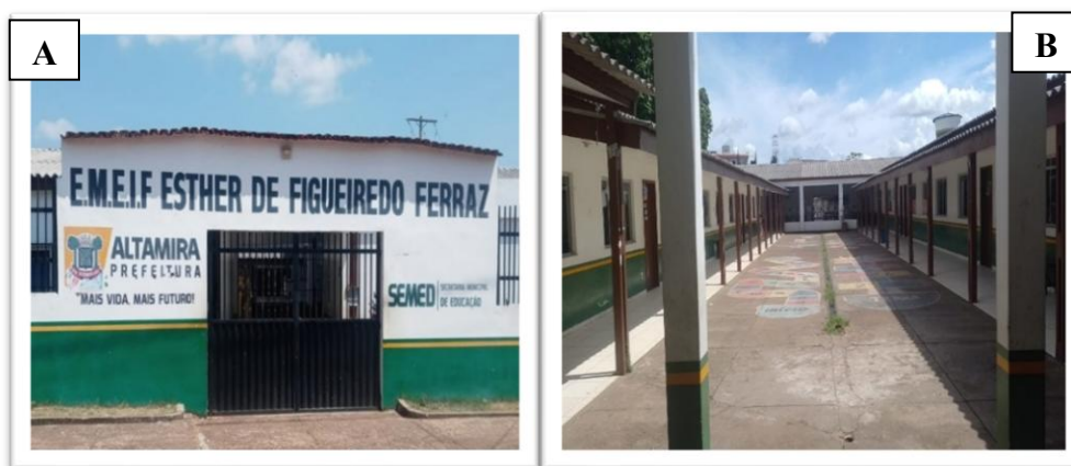
Figuras 3: A – Fachada da escola Ester Figueiredo Feraz; B – Parte interna da escola
