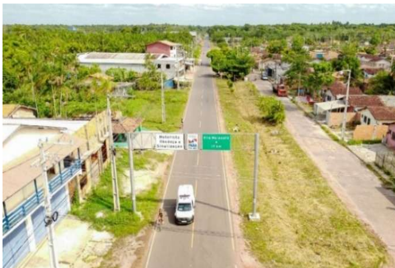
Figura 8 - Rodovia PA-407, via de escoamento da produção de açaí em Vila de Maiauatá, Igarapé-Miri- Pará.
