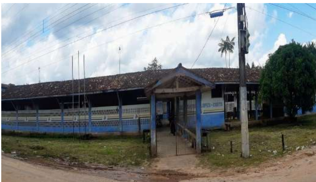
Figura 9 - Fachada da Escola Municipal de Ensino Fundamental Antônio Lopes da Costa.
