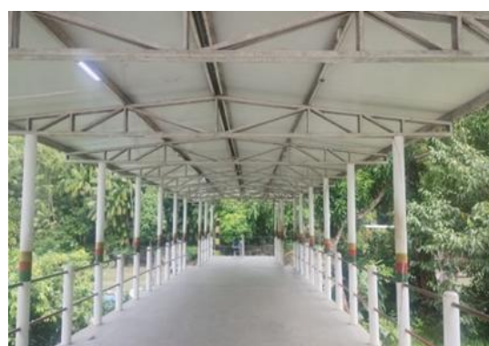
Figura 14 - Ponte da Escola
