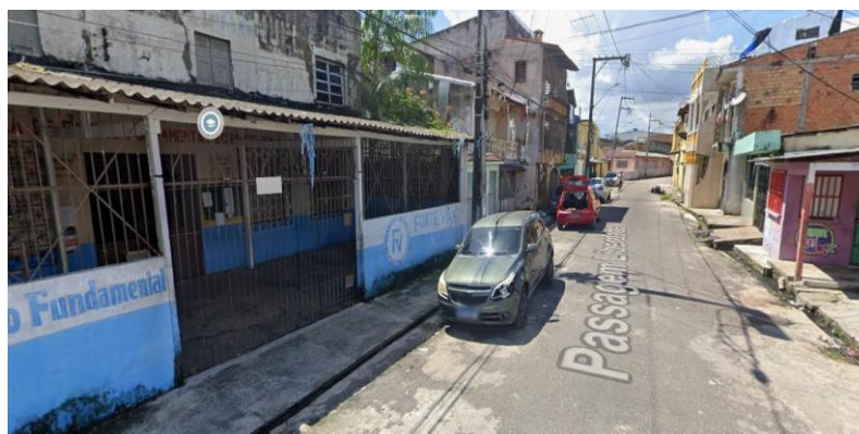
Figura 11: Fachada da escola
