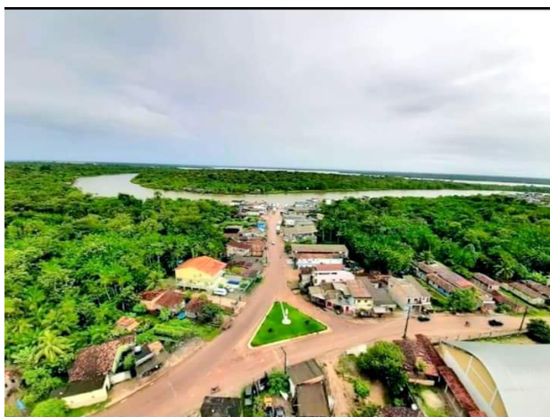
Figura 1 - Vista aérea da Vila de Carapajó
